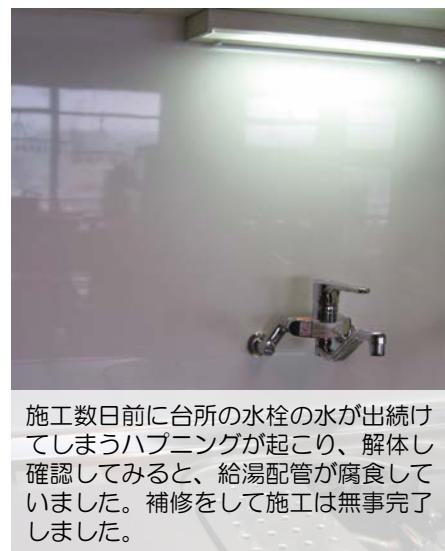
施工数日前に台所の水栓の水が出続けてしまうハプニングが起こり、解体し確認してみると、給湯配管が腐食していました。補修をして施工は無事完了しました。
