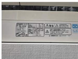
②室内機の銘板
