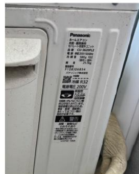
④室外機の銘板
